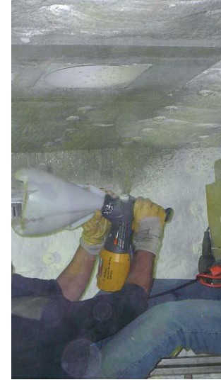
Auftragen der CERACOAT-Beschichtung
